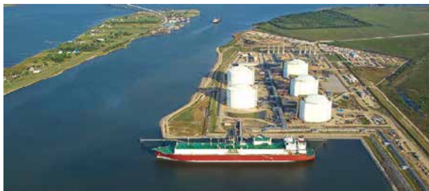
Cơ sở hóa lỏng và xuất khẩu LNG của Port Arthur LNG tại Texas. Nguồn: Hydrocarbon Technology
